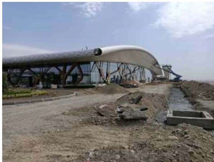
Aeroporto di Fuzuli, in costruzione
