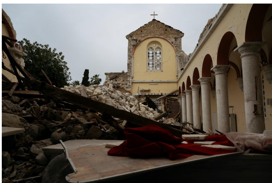
Figura 5 Danni nell'interno della Cattedrale dell'Annunciazione, Iskenđerun, 10 aprile 2023.
