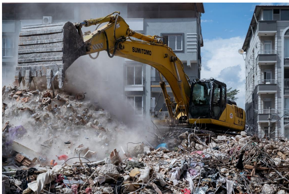
Figura 4. Una scavatrice in azione nel quartiere di Akevler. Hatay. 27 aprile 2023
