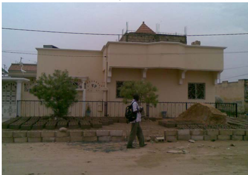
Foto 4. Abitazione di un migrante in costruzione (Kaolack)
