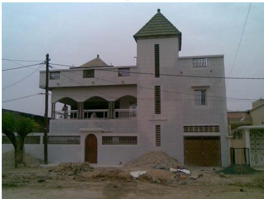
Foto 3. Abitazione di un migrante in costruzione (Kaolack)
